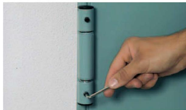
Cerniera portante dotata di viti per la registrazione verticale e sfere reggispinta.
